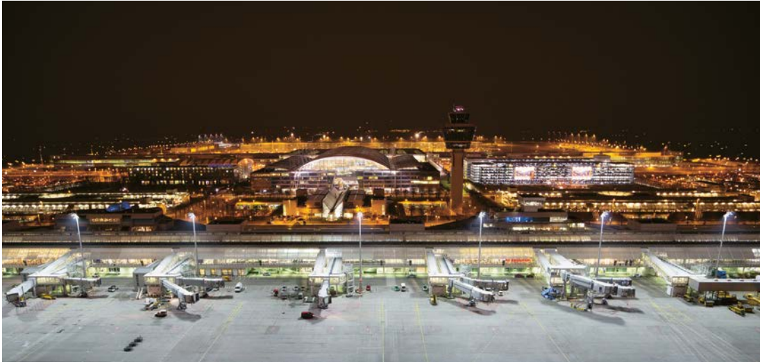
Nachts ist Klimaschutz sichtbar; Vordergrund: neue LED-Beleuchtung (weiß) / Hintergrund: bisherige Natriumdampflampen (gelb)
